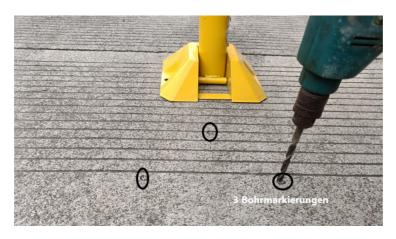
**Schritt 3**: Legen Sie nun das Parkschloss bündig über die Löcher, setzen die Spreizbolzen ein und klopfen diese mit dem Hammer (idealweiser Gummihammer) in die vorgesehenen Löcher.
