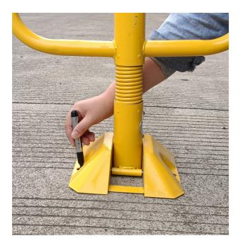
**Schritt 2:** Entfernen Sie das Schloss wieder und bohren Sie sorgfältig und gerade die 3 Löcher (Bohrtiefe Mindestens 10 cm)
